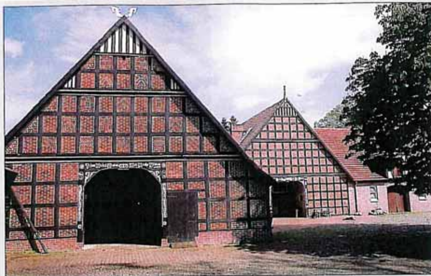
Die Fachwerkgebäude des Hofes Steinkamp-Warner in Varl stammen aus dem 19. Jahrhundert.
